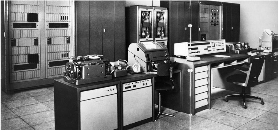
*Abb. 17. Steuerpult, Ein- und Ausgabegeräte und Maschinenschränke des von Karl Steinbuch bei der Firma Standard Elektrik Lorenz entwickelten Elektronischen Rechenautomaten ER 56, Aufnahme um 1960.*
